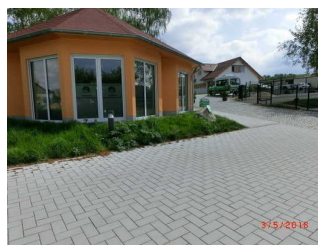
Parkplatz am Rezeptionshaus
